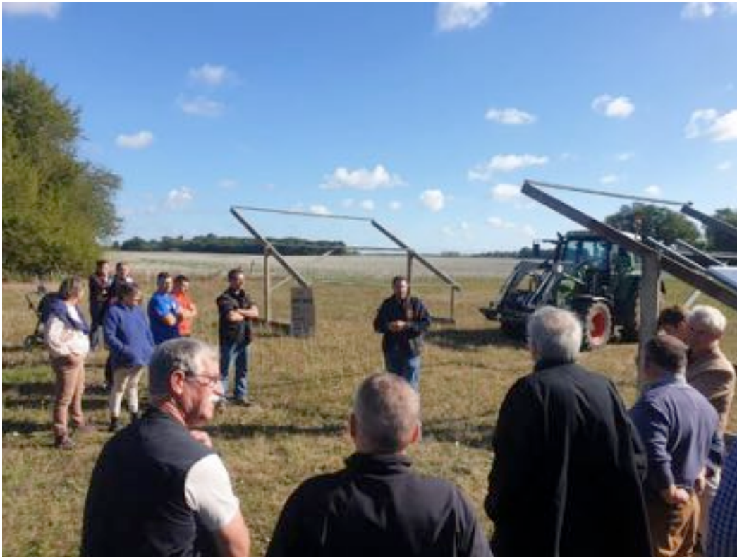
Découverte des futurs portants des panneaux photovoltaïques lors de la visite guidée du 17 septembre
